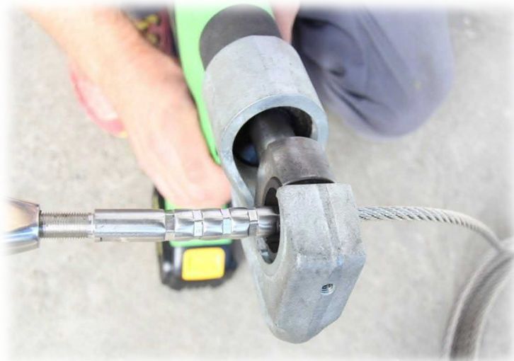
Bild: Verpressung mit Akku-Presszange
